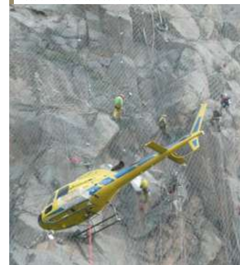
Estabilització talussos Roc del Corb
