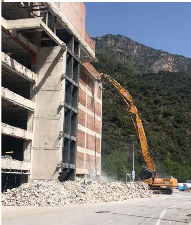
Enderroc edifici Punt de Trobada
