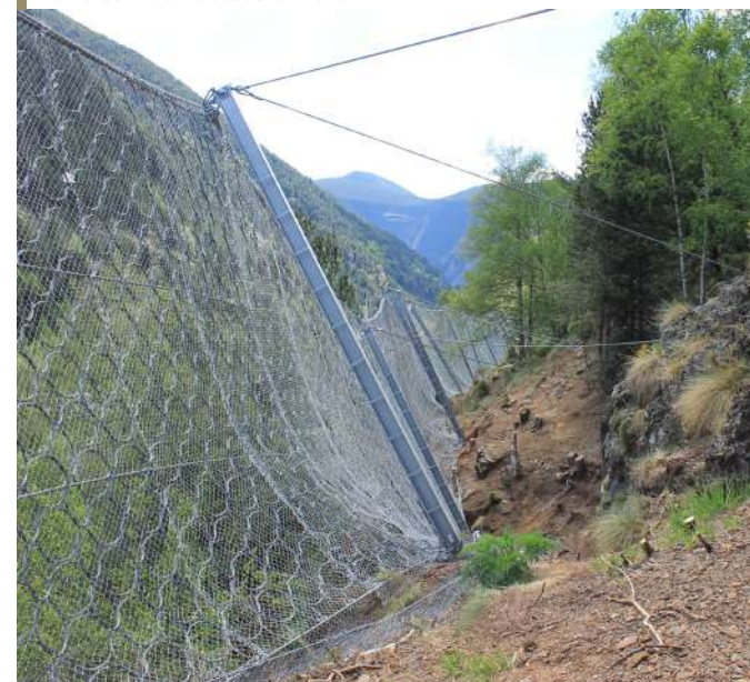
Barreres Bloc Rocosos la Trava
