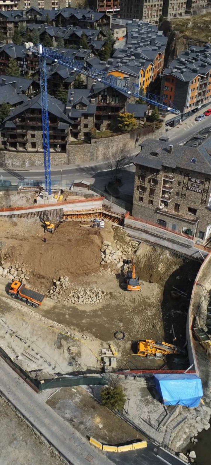
Excavació Edifici Isard Homes, El Tarter
