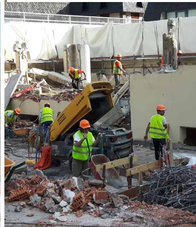
Enderroc edifici Andorra Telecom
