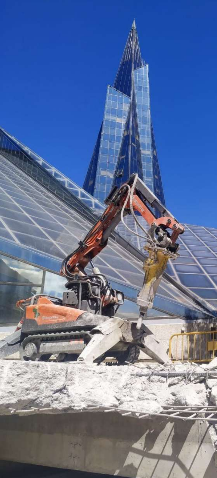
Robot elèctric de demolició
