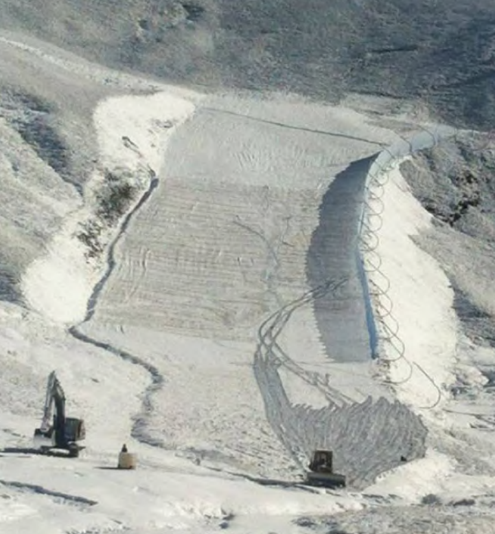
Exemple pista Riberal - obra acabada
