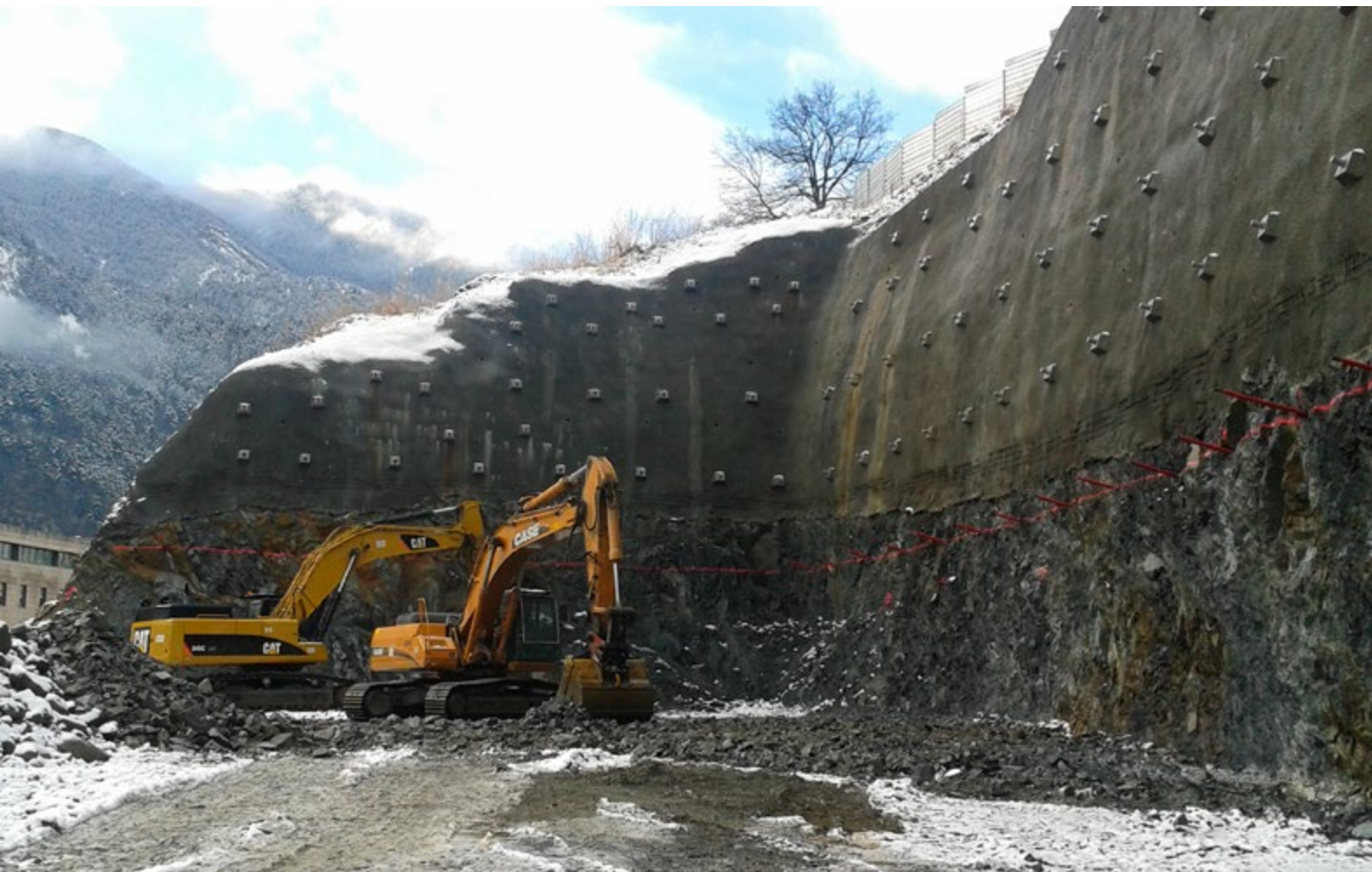
> Excavació Aparcament del Falgueró
