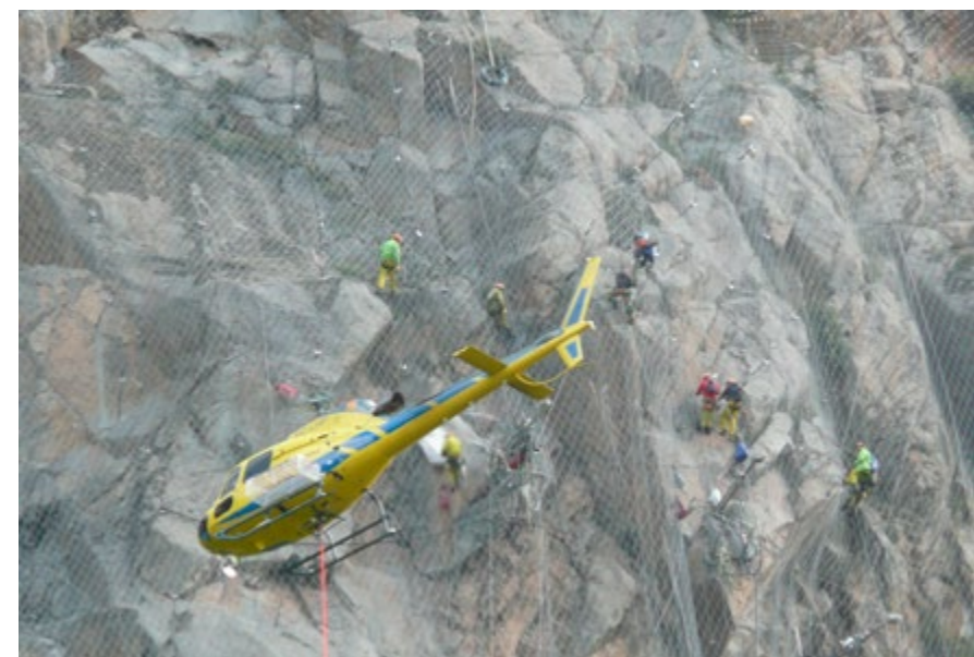
> Estabilització talussos Roc del Corb
