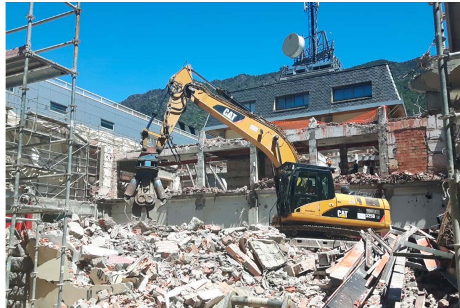
> Enderroc edifici Andorra Telecom
