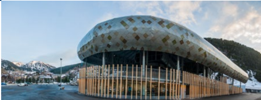
> Edifici del Telecabina del Tarter
